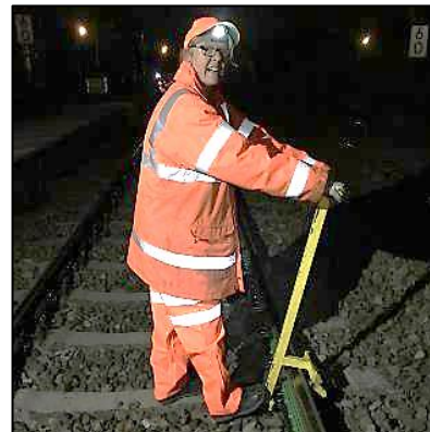
Figuur 11: Het montagegereedschap op de kop van de spoorstaaf
