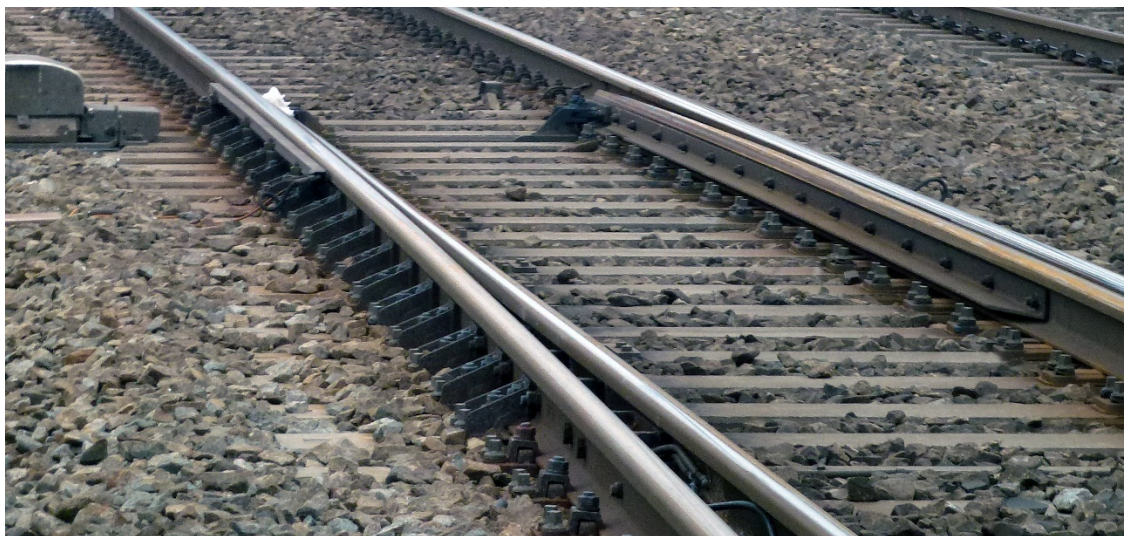
Afbeelding 11: Wissel met hoeklijnverstijving op de tong
