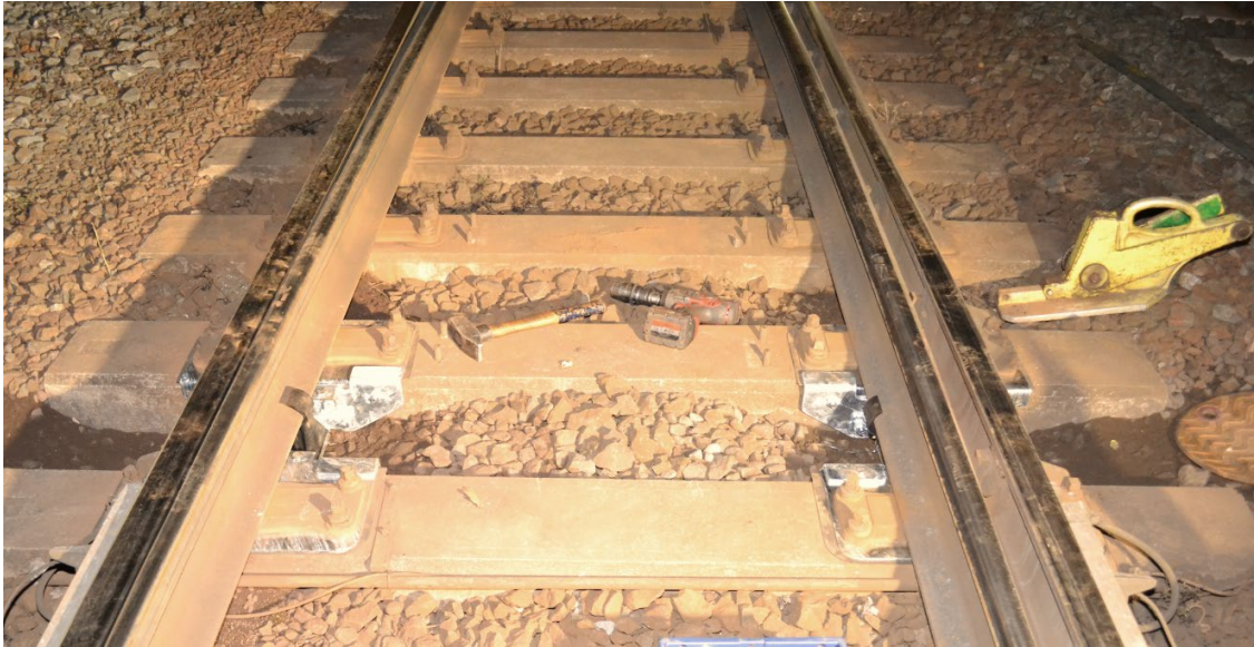
Afbeelding 5: Plaatsing spookrik in het liggervak achter de plaats waar het frame wordt ingebouwd
