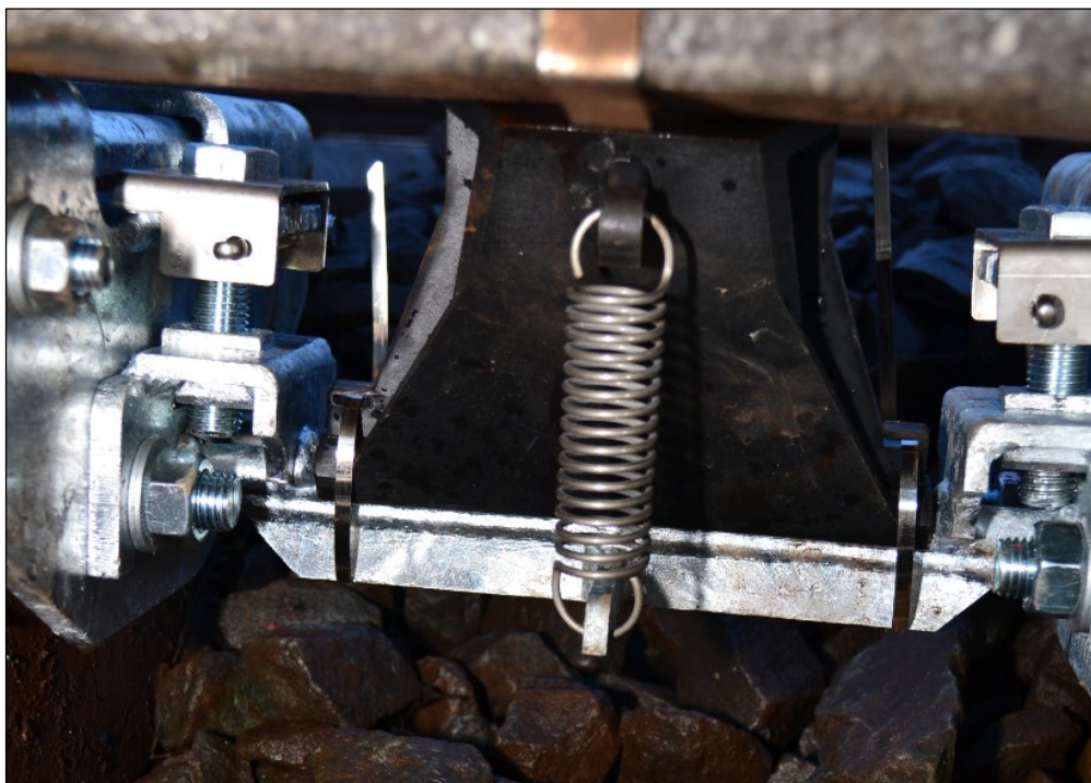
Afbeelding 7: Borging hoogtebout met behulp van de borgplaat en pendelblok met RVS tyrap
