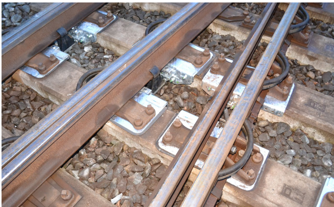
Afbeelding 13: DeltaSwitch in een Engels Wissel
