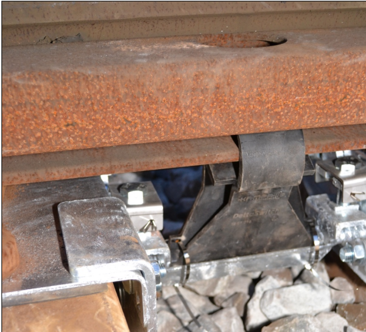
Afbeelding 12: DeltaSwitch pendelblok onder de tongverstijving (koker)
