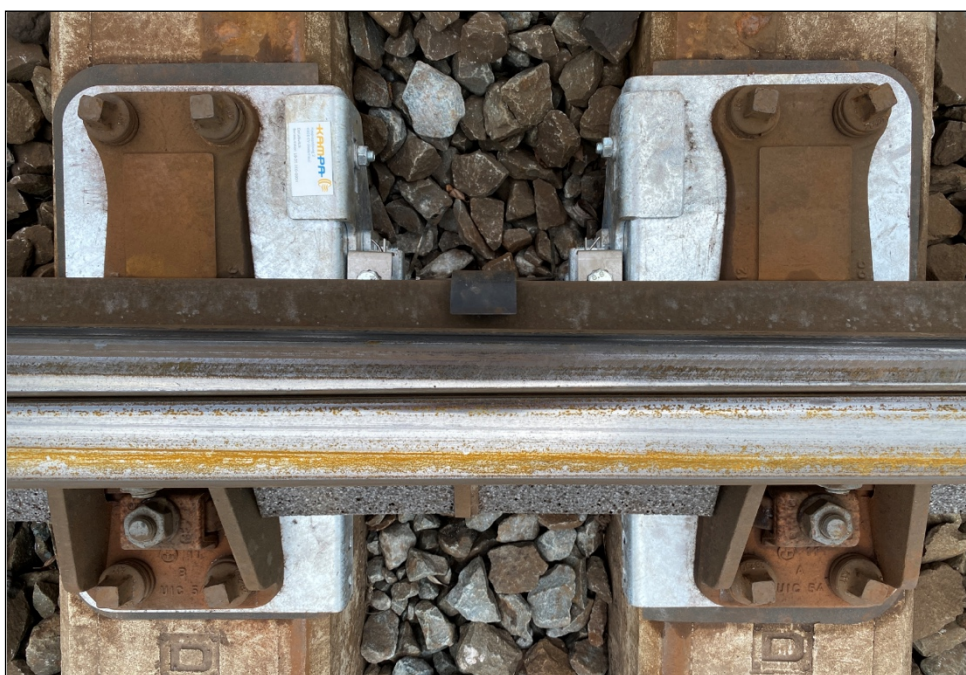
Afbeelding 8: Overzicht en details van een ingebouwde DeltaSwitch
