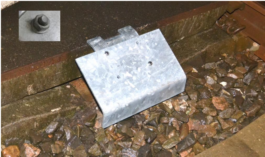
Fig. 10. Binnenste opsluithaak gemonteerd en voorzien van oploopp plaat.
