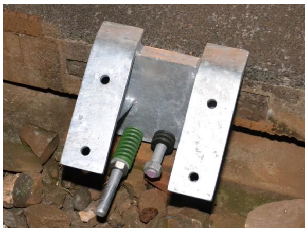
Fig. 6. Opsluithaak gemonteerd op de binnenplaat
