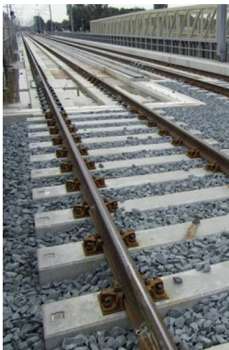
ShimLift op overgangen bij kunstwerken. Utrecht - Houten
