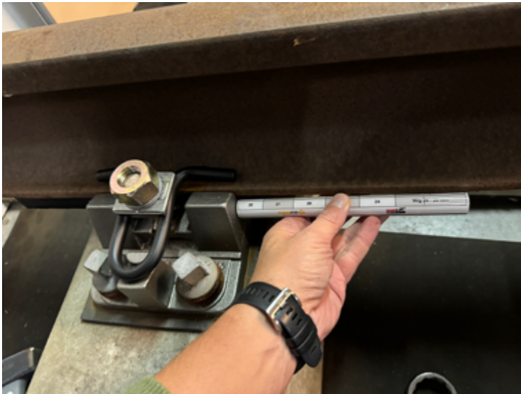
Afbeelding 9 Controle positie vulwig
