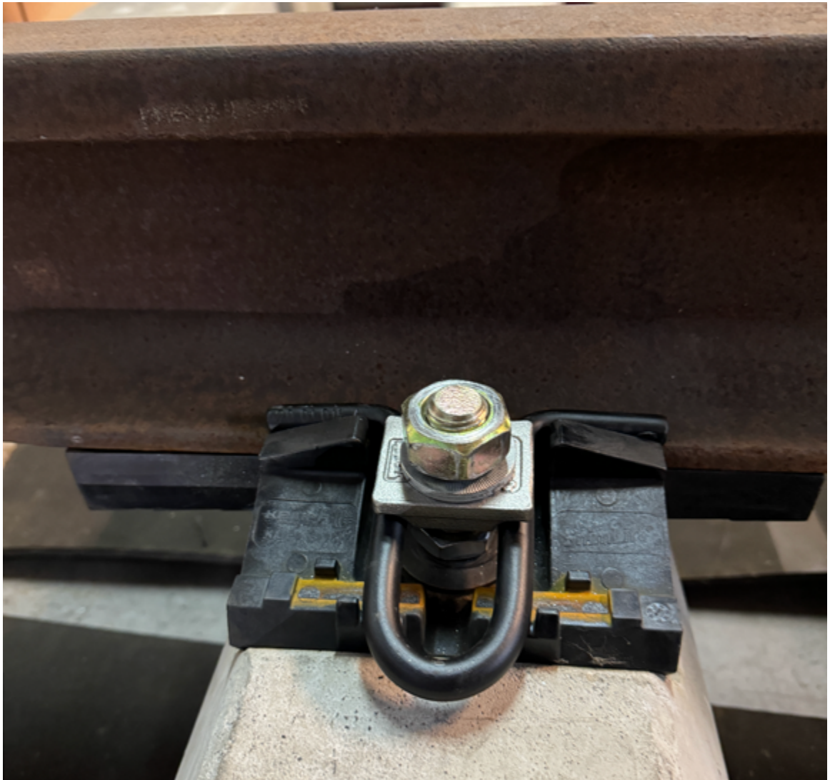
Afbeelding 20 De grote moer met drukplaat wordt gebruikt om de spoorstaaf vast te klemmen
