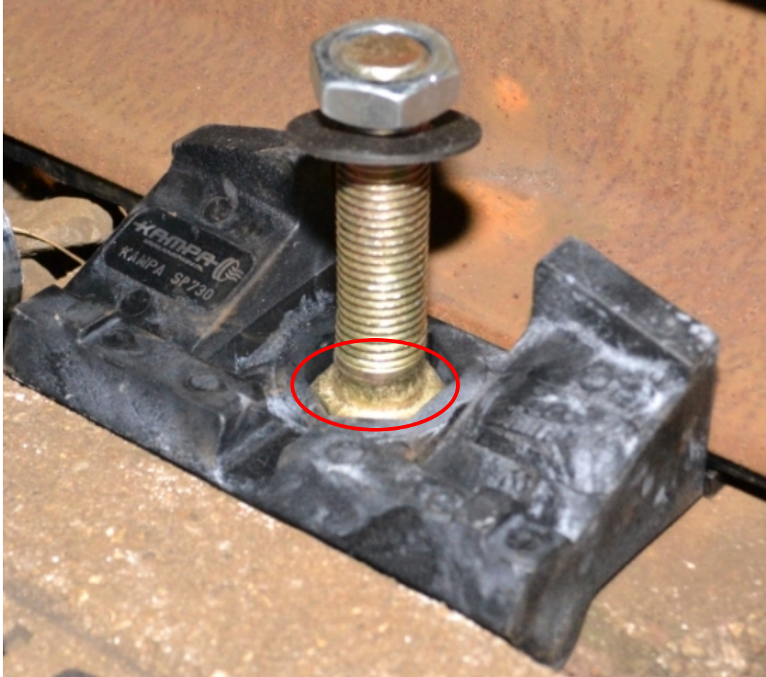
Afbeelding 22 Aandachtspunten bij het aandraaien van de lage en de grote moer
