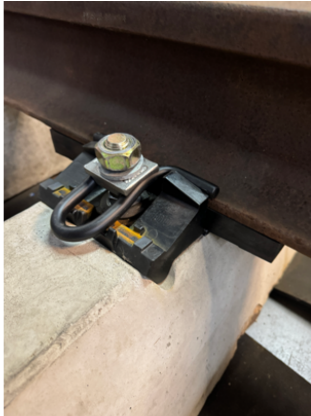
Afbeelding 14 ShimLift type S op een NS90 dwarsligger
