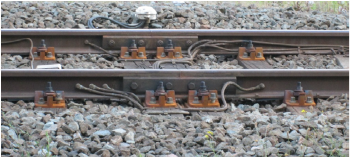
Afbeelding 11 Geïsoleerde klemplaat voor ShimLift type R (boven- en onderkant)
