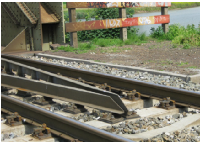
Afbeelding 10 Uitgevulde ontsporingseleiding
