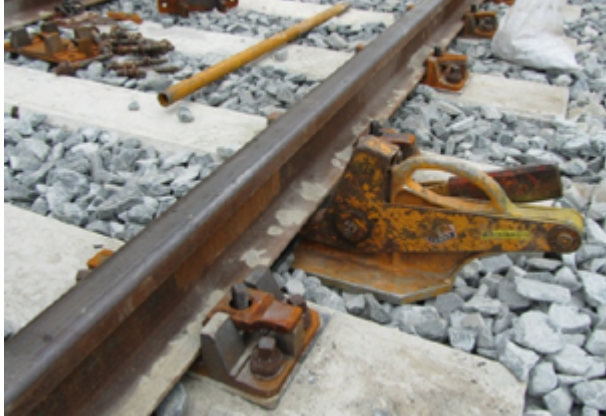
Afbeelding 7 Opgekrikte spoorstaaf
