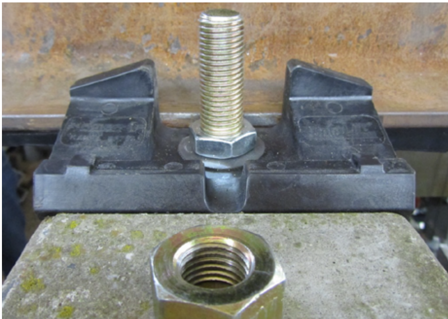
Afbeelding 18 De lage moer met dunne schotelveer wordt gebruikt om de opsluitblokken vast te zetten
