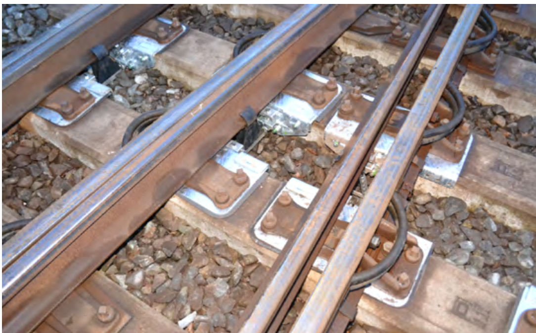
Afbeelding 17: DeltaSwitch in een Engels Wissel
