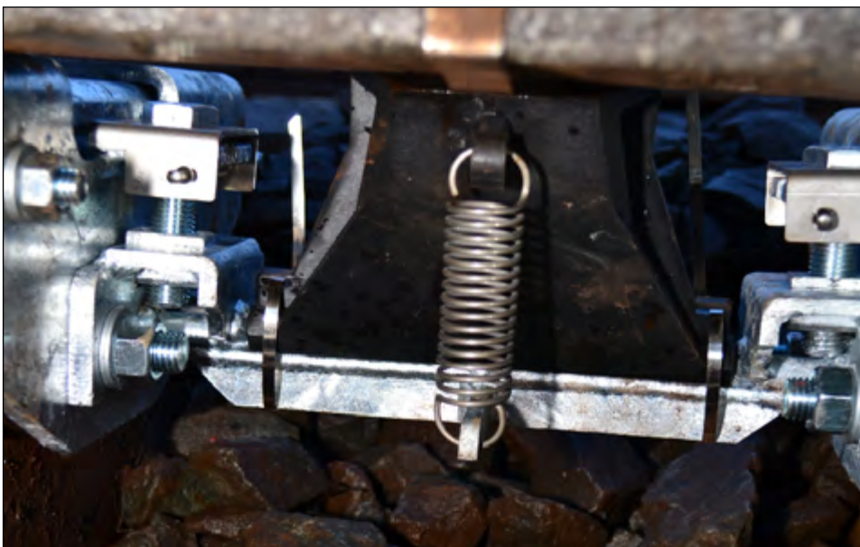
Afbeelding 7: Borging pendelblok met RVS tyrapen
