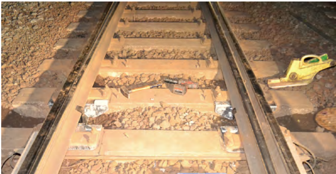
Afbeelding 4: Plaatsing spookkrik in het liggervak achter de plaats waar het frame wordt ingebouwd
