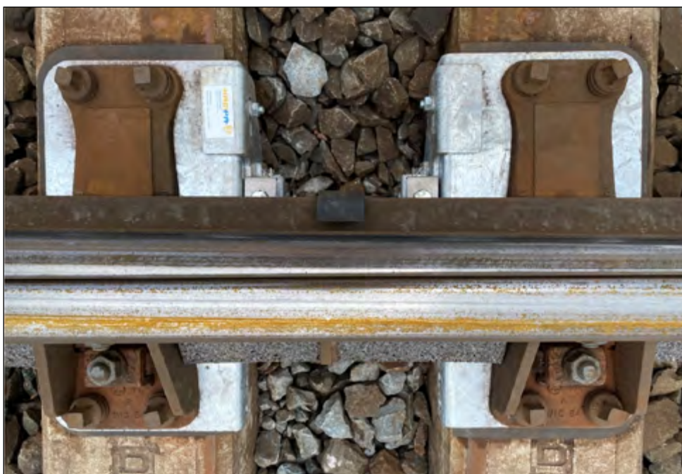
Afbeelding 8: Overzicht en details van een ingebouwde DeltaSwitch
