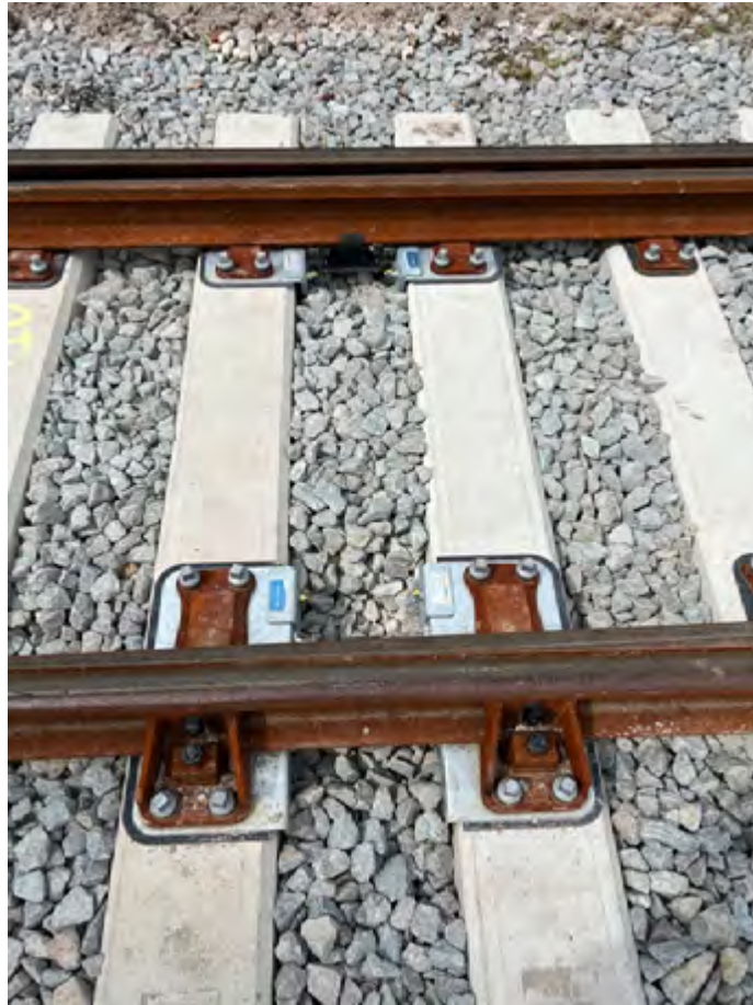
Afbeelding 13: Identificatie is aanwezig op elke DeltaSwitch (blauwe plaatje op flensplaat)
