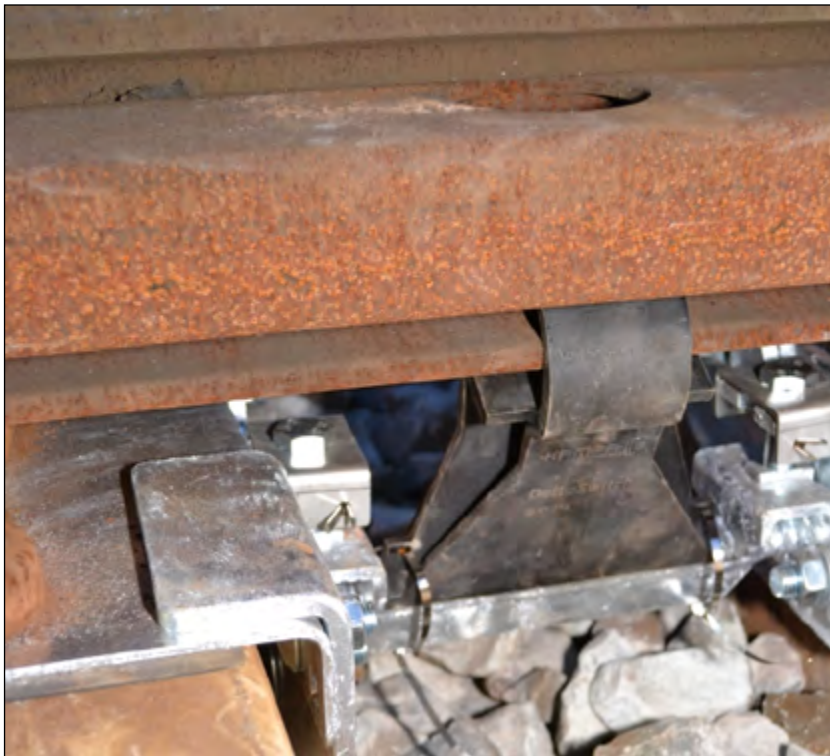
Afbeelding 16: DeltaSwitch pendelblok onder de tongverstijving (koker)
