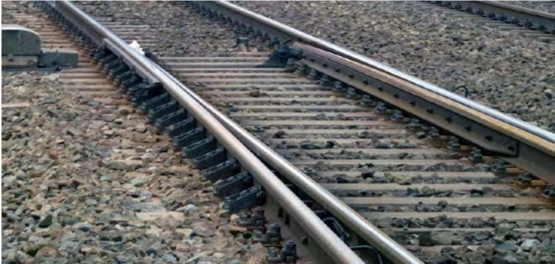
Afbeelding 15: Wissel met hoeklijnverstijving op de tong
