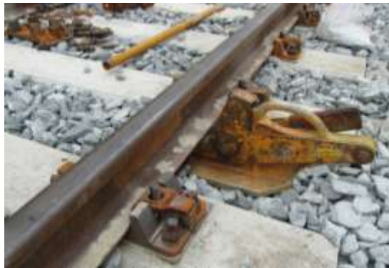
Afbeelding 9 Opgekrikte spoorstaaf
