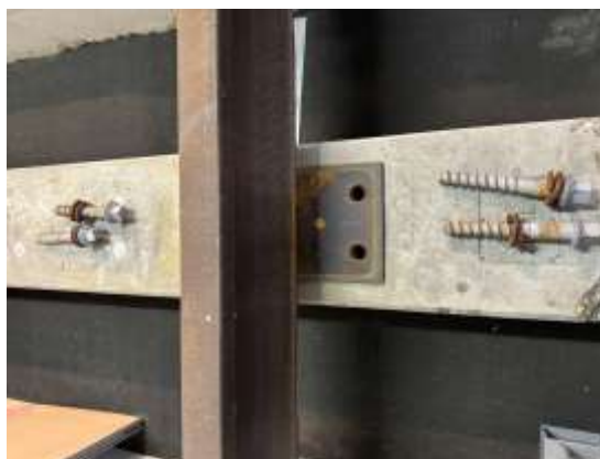
Afbeelding 10 Dwarsligger met onderlegplaat
