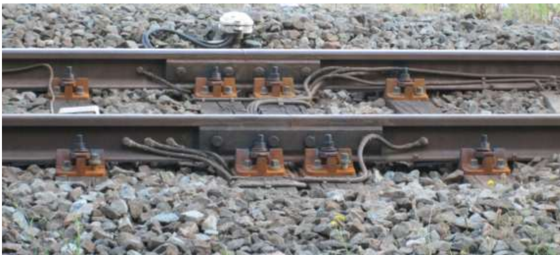
Afbeelding 25 Geïsoleerde klemplaat voor ShimLift type R (boven- en onderkant)
