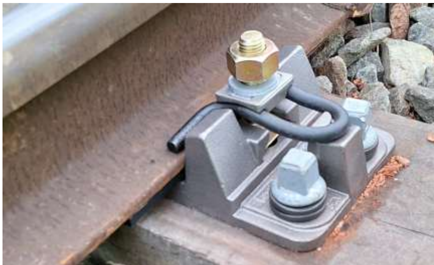
Afbeelding 11 ShimLift rughellingplaat gemonteerd op een (houten) ligger
