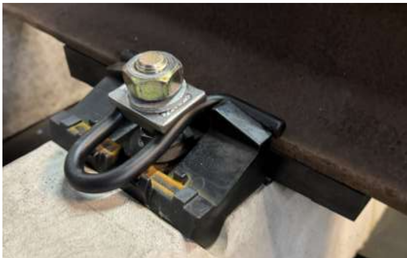
Afbeelding 14 ShimLift type S op een NS90 dwarsligger
