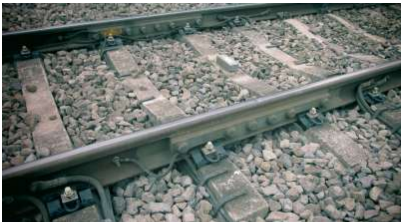
Afbeelding 22 ShimLift onder zwevend opgelegde ES-lassen
