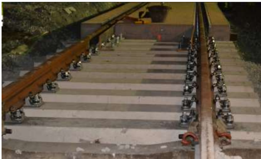
Afbeelding 7 Aanleg overgang met ShimLift bij vernieuwing
