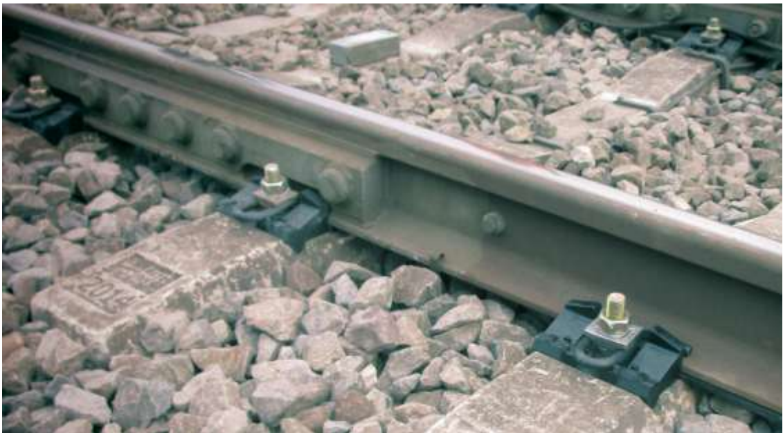
Afbeelding 20 ShimLift S op NS90 rond ES-lassen
