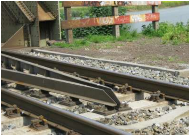
Afbeelding 21 Uitgevulde ontsporing geleiding
